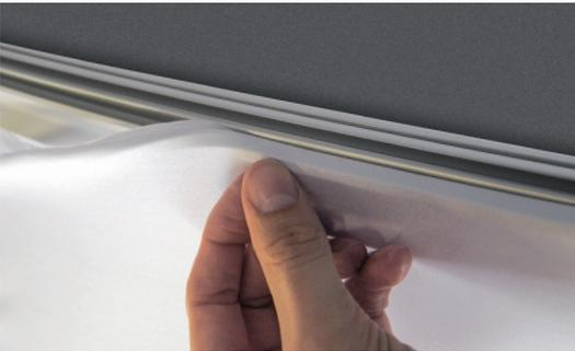
1. Führen Sie das Kederprofil am oberen Ring in die vorgesehene Nut des Profils ein. Achten darauf, dass Hände entsprechend sauber sind um eine Verschmutzung vorzubeugen.
